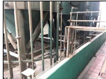
รูปที่ 6 แทงค์รวบรวมน้ำเสียไม่อันตราย (Non-hazardous liquid waste storage tank) ขนาด 125 ลูกบาศก์เมตร ในปัจจุบัน มีจำนวน 3 แทงค์
