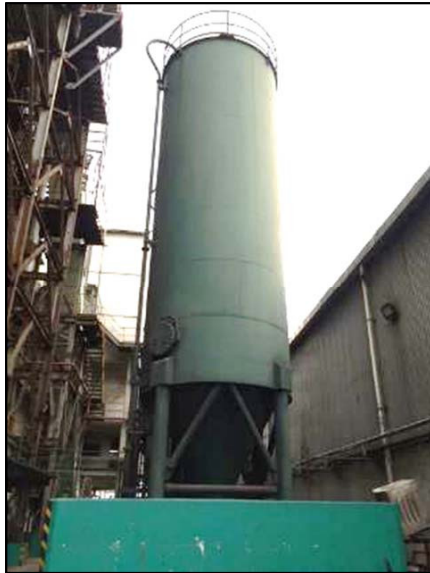
รูปที่ 6 แทงค์รวบรวมน้ำเสียไม่อันตราย (Non-hazardous liquid waste storage tank) ขนาด 125 ลูกบาศก์เมตร ในปัจจุบัน มีจำนวน 3 แทงค์
